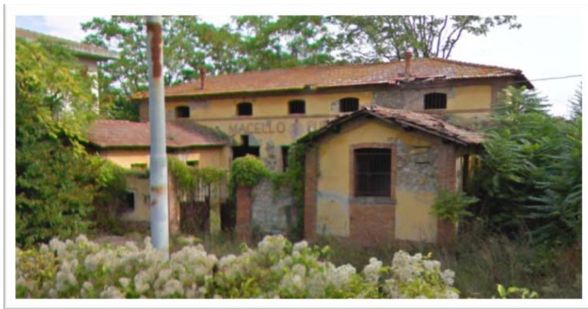
Fig. 5 – Ex Macello – intervento R3
