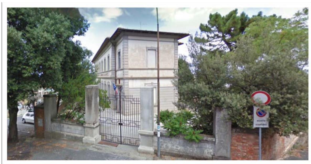
Fig. 4 - Le scuole dismesse di Via Roma – intervento R2
