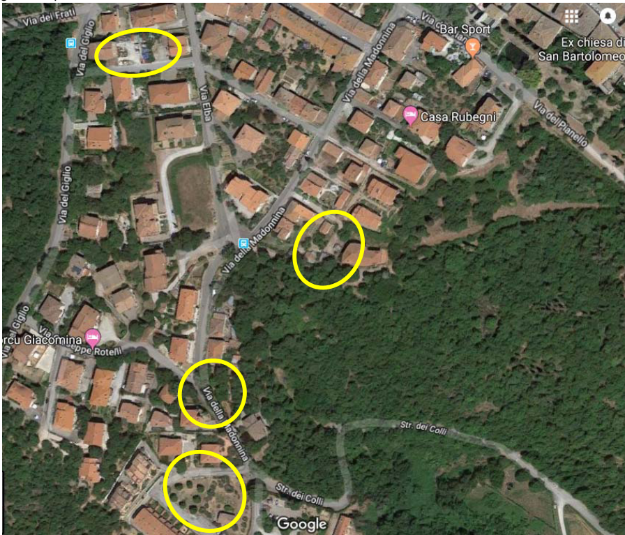
Fig. 2 Inquadramento dell'area di intervento su ortofoto 2013
