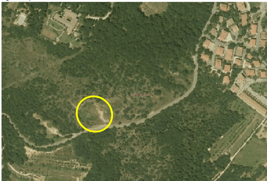
Fig. 2 Inquadramento dell'area di intervento su ortofoto 2013
