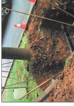
Problemi di compatibilità: esempio di interferenza tra apparati radicali e servizi
