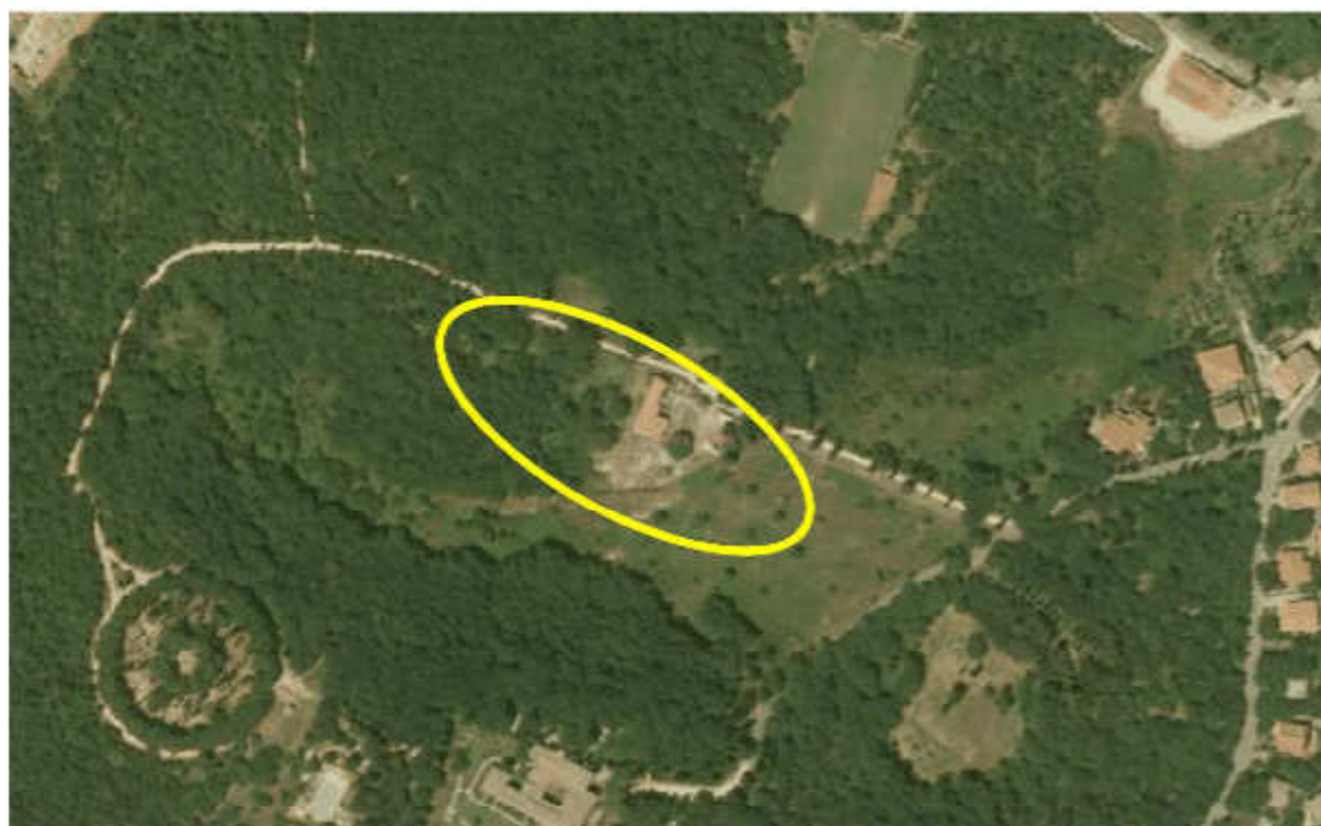
Fig. 2. Inquadramento dell'area di intervento su ortofoto 2013
